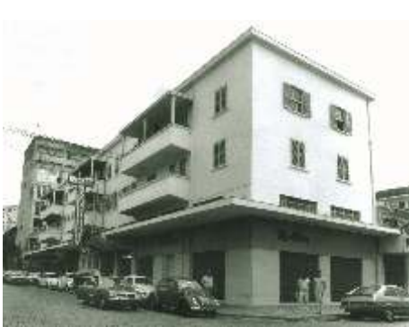
Parte integrante do Patrimônio Imobiliário da CBS desde 1981, os Edifícios Comercial A e B foram algumas das primeiras edificações da Vila Santa Cecilia, no início da década de 40.
