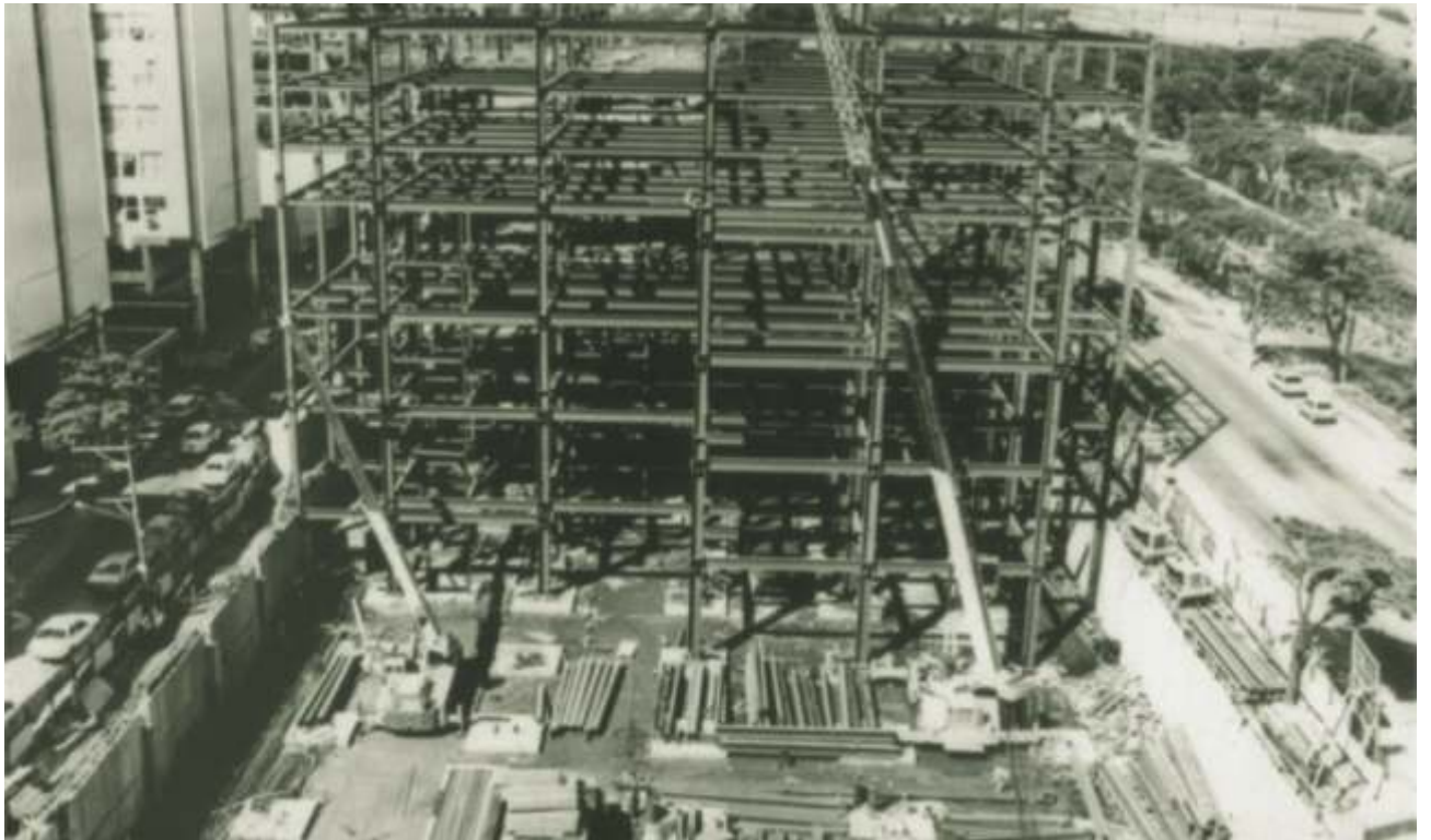
Esqueleto do Sider Shopping Center em estrutura metálica, fornecida pela FEM.
